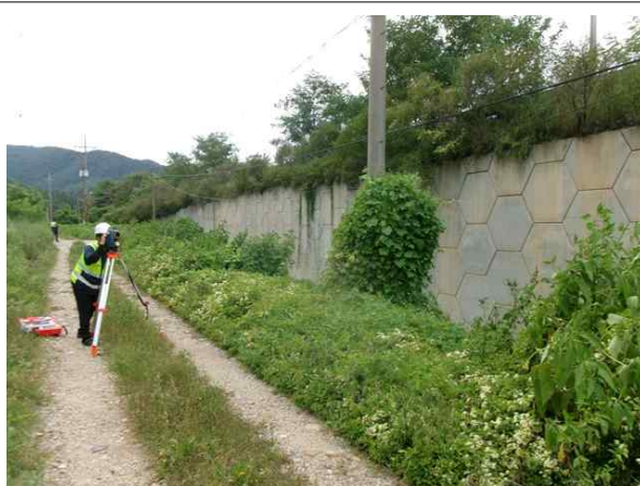
광파기를 이용한 측량 작업
