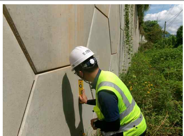
경사계를 이용한 경사도 측정
